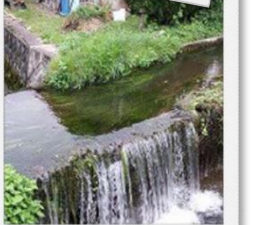
立体交差水路
